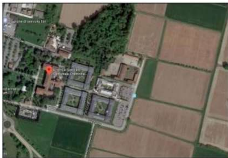
L'area interessata al fotovoltaico è quella a destra di Cremona Solidale
