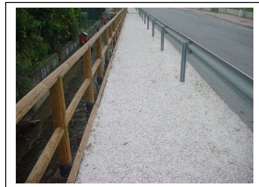
Separazione dal traffico veicolare
