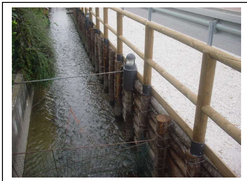
Esempio di sostegno delle rive
