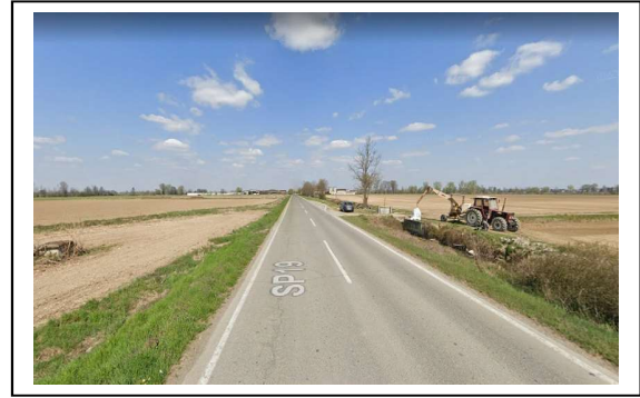
Posizione futuro attraversamento semaforizzato
