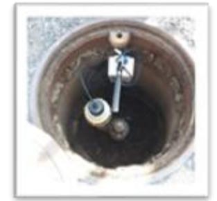
Vantaggi rispetto alla ricerca tradizionale: la ricerca eseguita tramite squadre di ricerca perdite mediante sistema acustico oltre a risentire della presenza di rumori esterni che possono compromettere l'ascolto permette solo una rilevazione momentanea e non continua.
